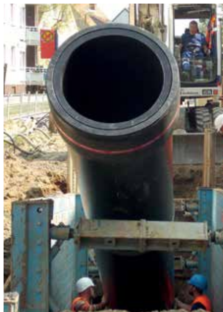
PE-Rohrstück mit vormontierter FRIAFIT Muffe AM d 900 auf dem Weg in den Graben
