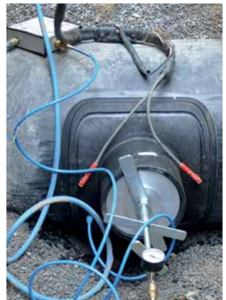
Schweißung Abwassersattel ASA VL d 630/225
