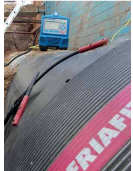
Schweißung der FRIAFIT Muffe AM d 900 mit dem FRIAMAT prime Schweißgerät
