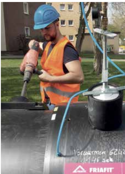
Montage mittels Vakuumpanspanntechnik und Anbohrung des Stutzensattels SA XL d900/160
