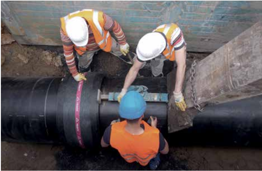
Montage der FRIAFIT Muffe AM d 900 im Graben
